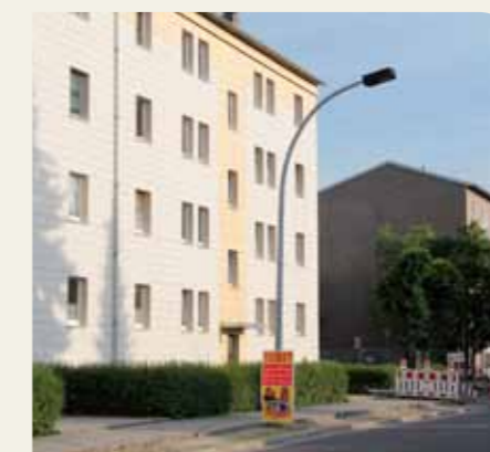
Baumaßnahmen Lange Straße
