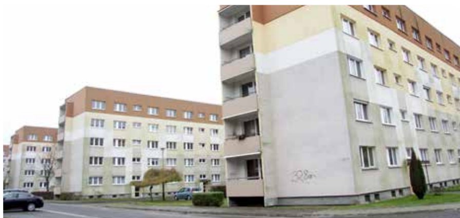
Drei Wohnhäuser im Sachsenring werden nach gründlicher Abwägung zurückgebaut.
