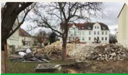
Einst alte Villa, jetzt Freifläche für Neues.
