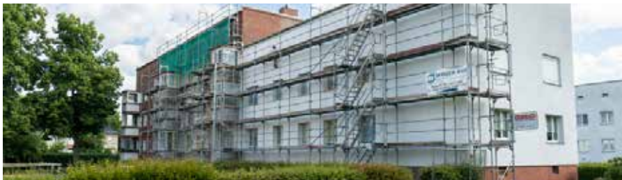
Zum Zeitpunkt der Fotoaufnahme stand die Fassadensanierung des Gebäudes in der Friedenstraße 70 bereits kurz vor der Fertigstellung.
