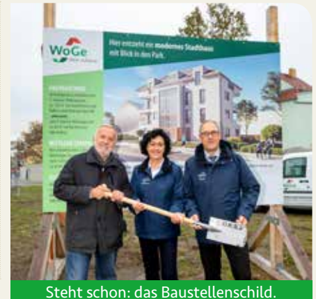
Steht schon: das Baustellenschild.
