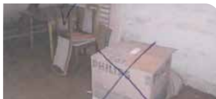
Brandlasten und Hindernisse vermeiden!
