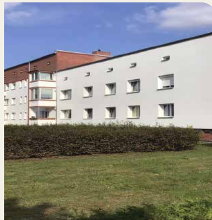
Blick auf die frisch renovierte Fassade unseres Wohnhauses in der Friedenstraße.
