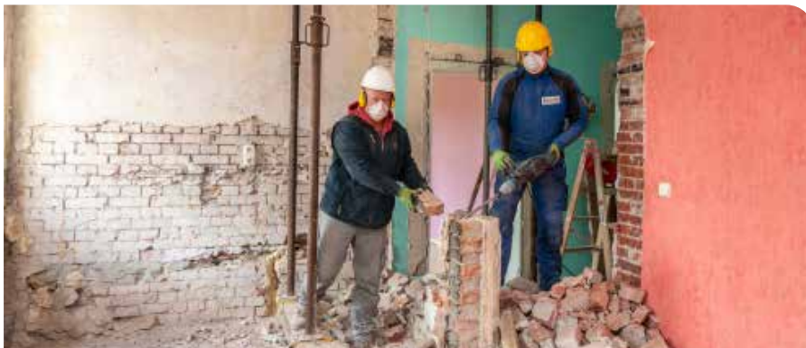
Kaum wiederzuerkennen: An der Bürgerheide werden Wohnungen von Grund auf modernisiert.
